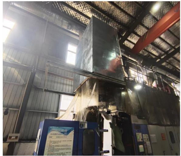
有机废气收集密闭罩
